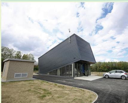
Crpna stanica sustava javnog navodnjavanja VPŽ
